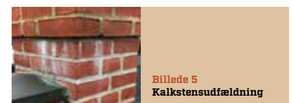
Billede 4 Kalkstensudfældning
