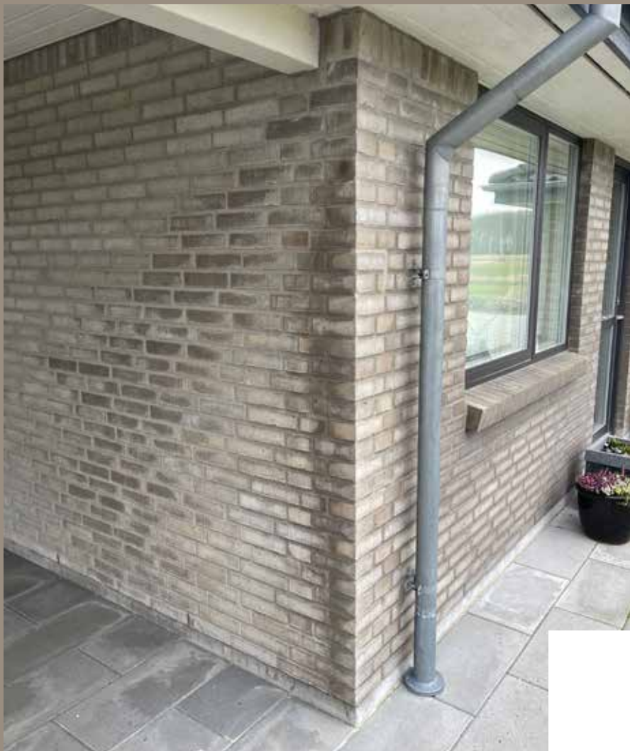
Vejrligsfacade med udhæng
